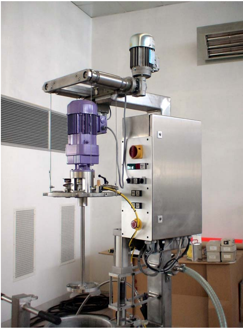
Rührwerk, Seilzug, Steuerung und Förderpumpe
